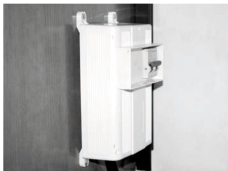
Fig. 57 : Interrupteur principal (disjoncteur différentiel)
