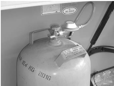
Fig. 86: Bouteille de gaz avec détendeur
